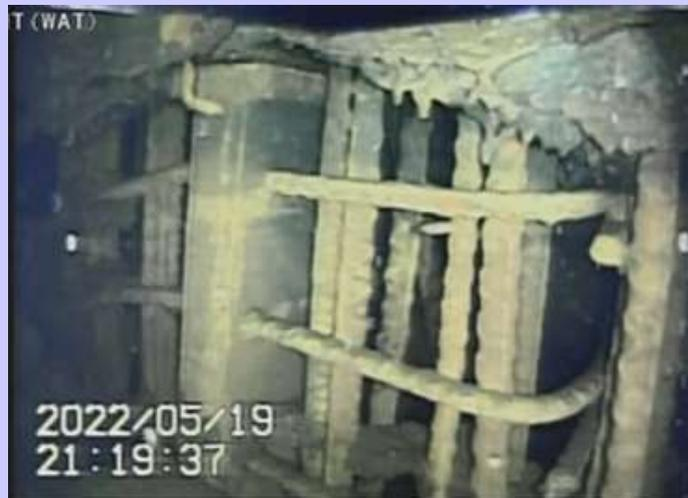
メルトダウンした原子炉圧力容器下の厚さ1m以上あるはずの土台をロボットカメラが撮影！（東電 HP）
